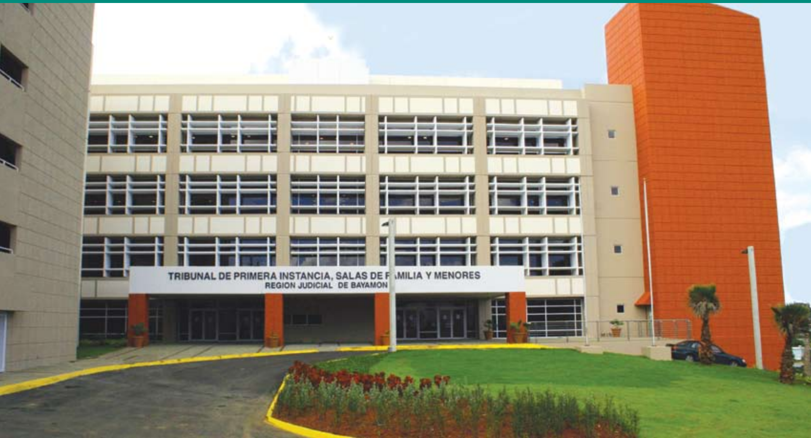
Nuevo Edificio del Tribunal y Sala de Menores de Bayamón.
